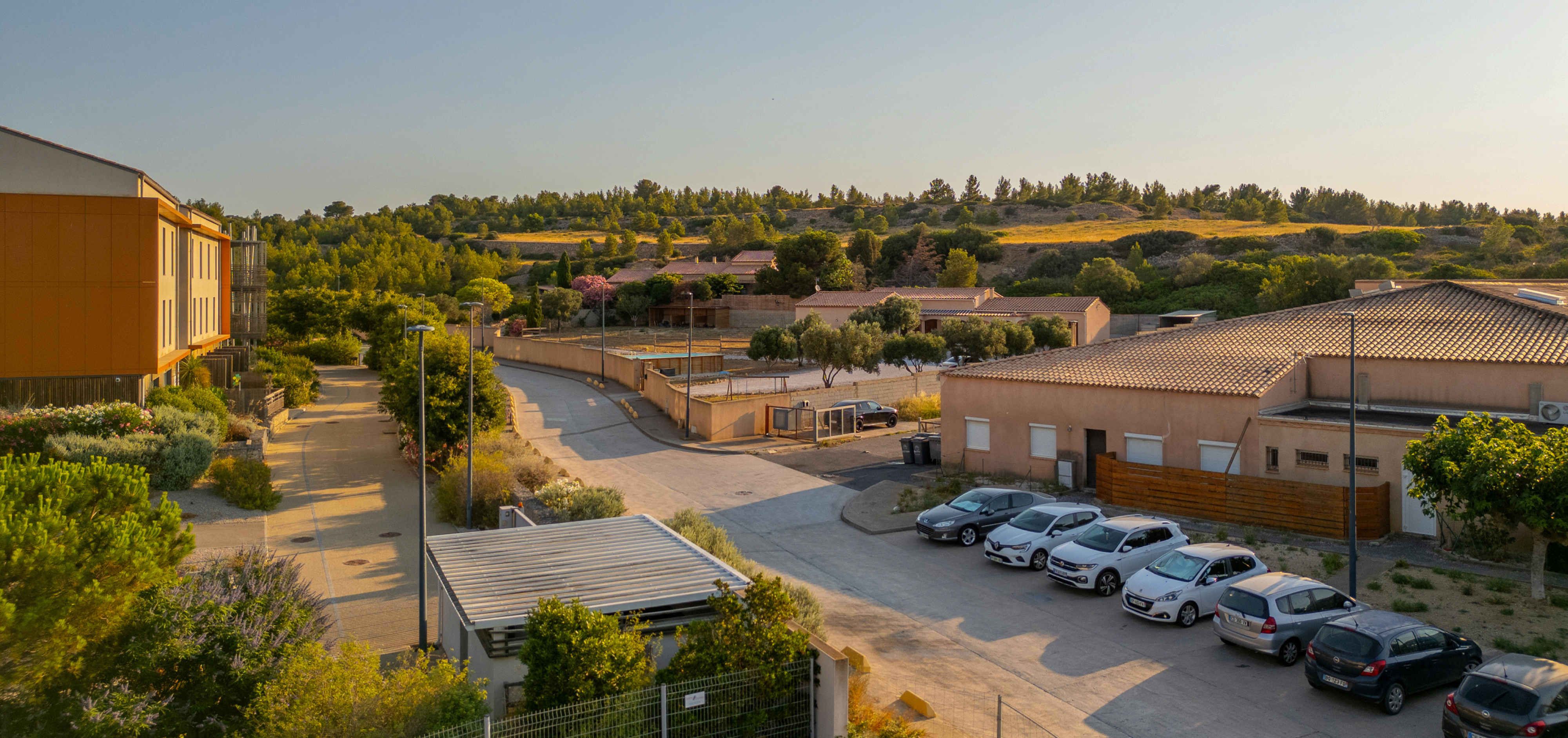
Vue réelle appartement - Étage 2 (côté gauche façade - côté rue)
