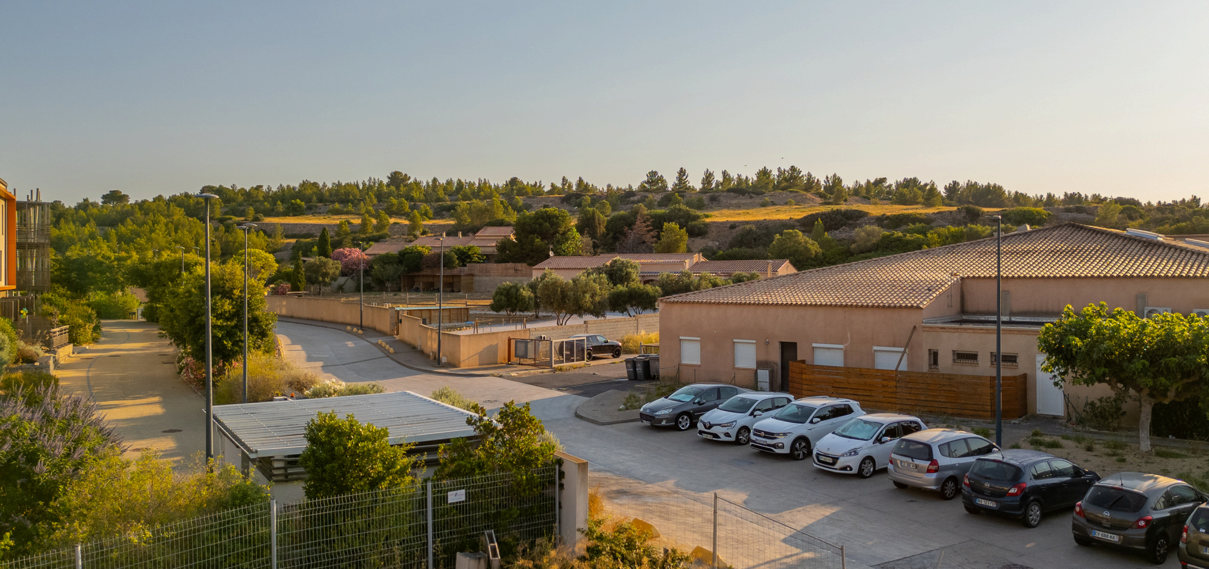
Vue réelle appartement - Étage 1 (côté gauche façade - côté rue)
